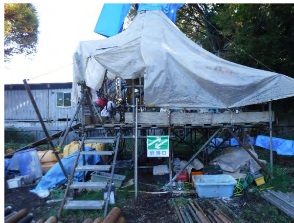
水理構造調査ボーリング（秦野市）
