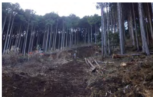
水源林の基盤の整備
