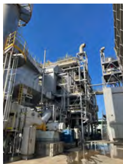
木質バイオマス発電所 （横須賀市）
