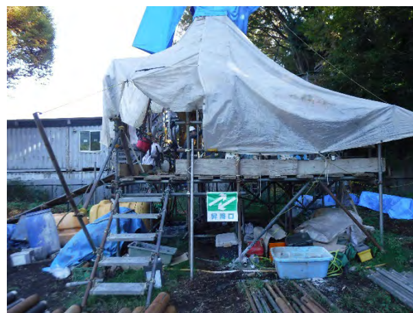
水理構造調査ボーリング（秦野市）
