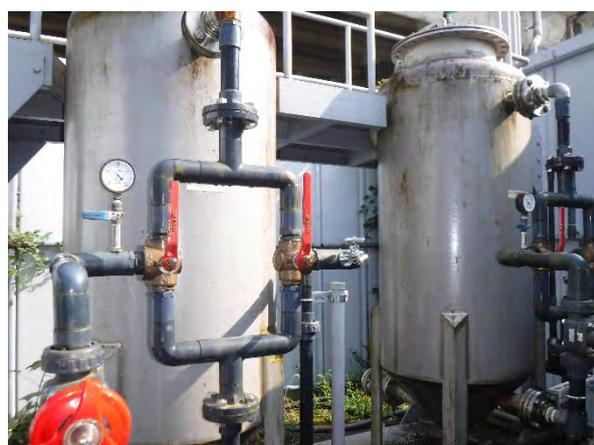
有機塩素系化学物質で汚染された地下水を施設の装置に通すことにより浄化を図る。
