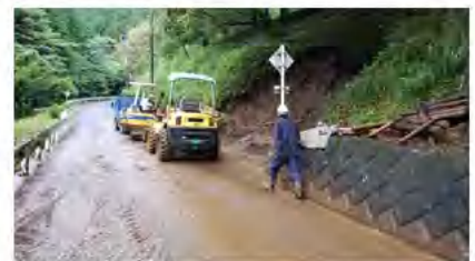
<土砂除去作業>
