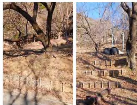
土留めの様子
