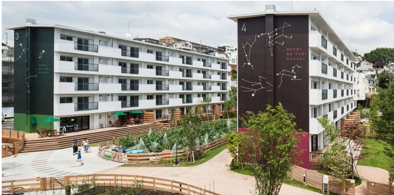
小田急不動産(株)HPより
