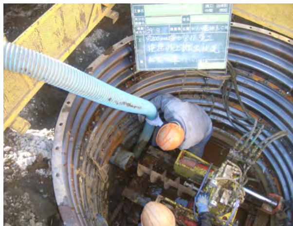
公共下水道の整備（相模原市）
