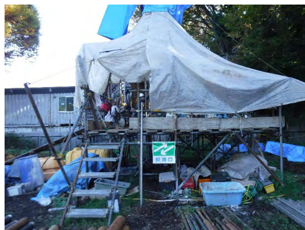
水理構造調査ボーリング（秦野市）
