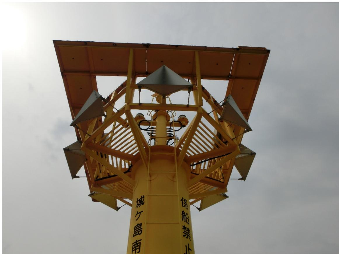
南西沖浮標の上部構物や配線などの固定の確認を行い不良個所が見つければインシロックやビニールテープなどで補修を行う。
