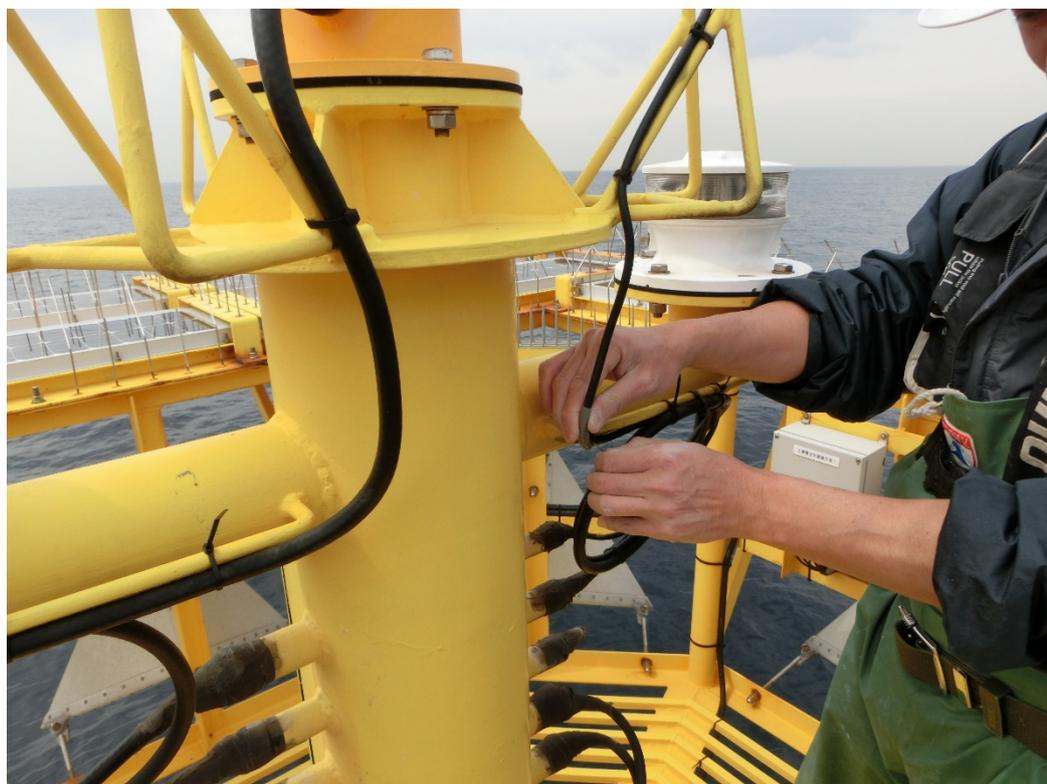
塗装が終わり乾燥してから流向流速計センサーを水中に戻す。
