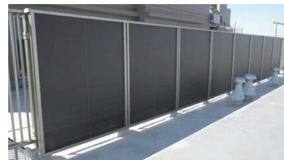
▲薄膜シリコンハイブリッド太陽電池
