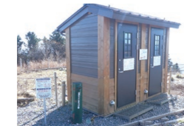
三ノ塔休憩所の環境配慮型山岳公衆トイレ
