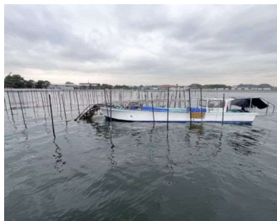
支柱杭を確認
