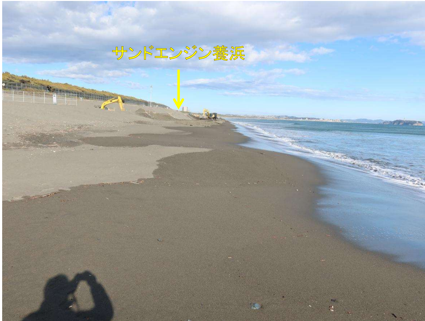
写真-12 サンドエンジン養浜箇所で前進した汀線
