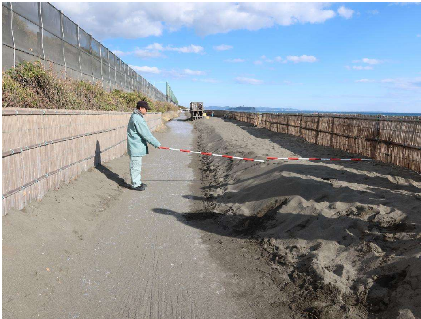
写真-8 幅約5 mの自転車道
