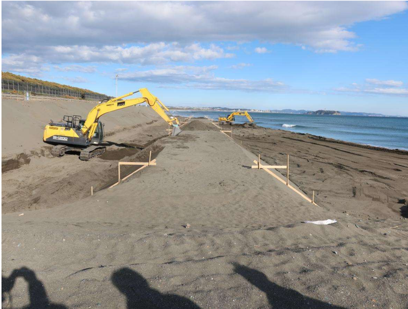
写真-13 サンドエンジン養浜での土砂量検収のための盛り土
