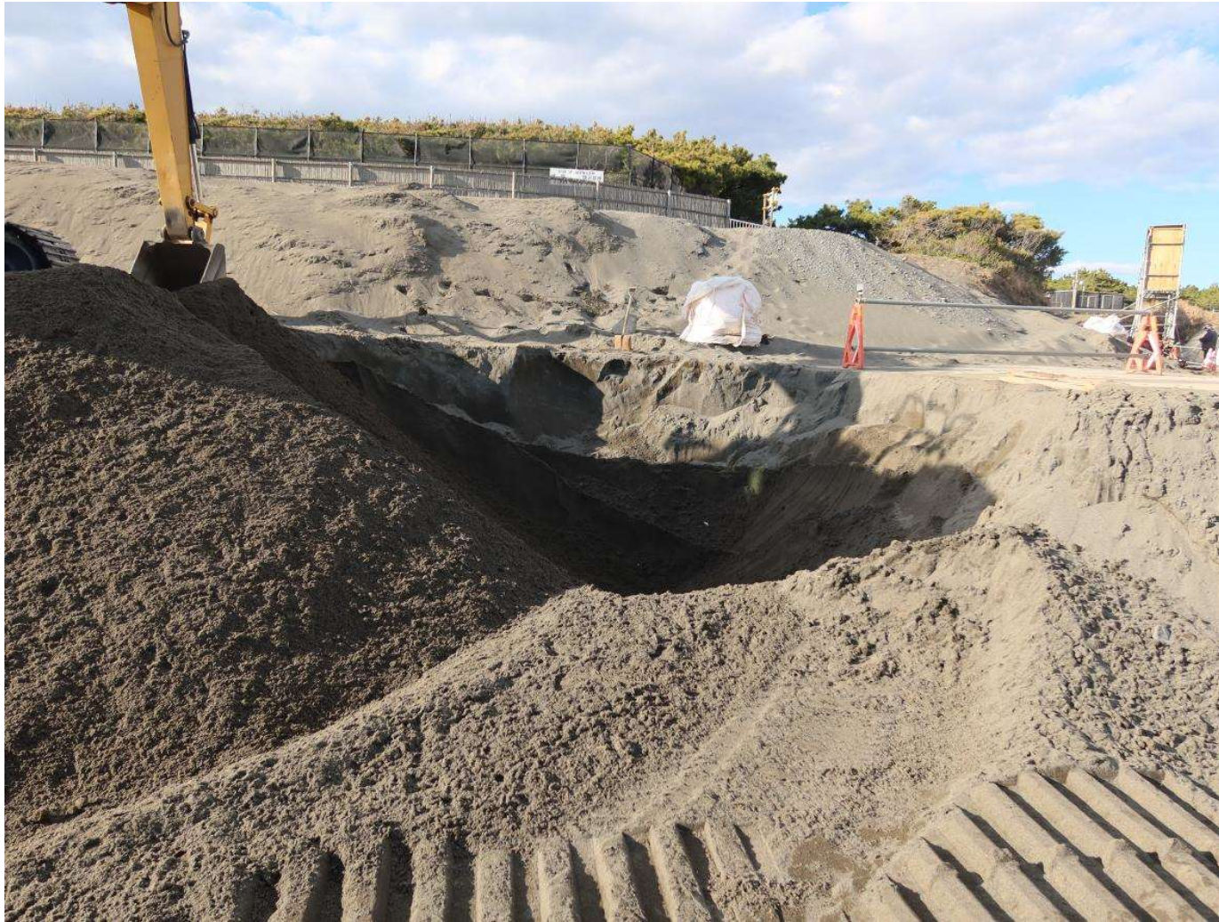
写真-18 養浜土砂の仮置き場
