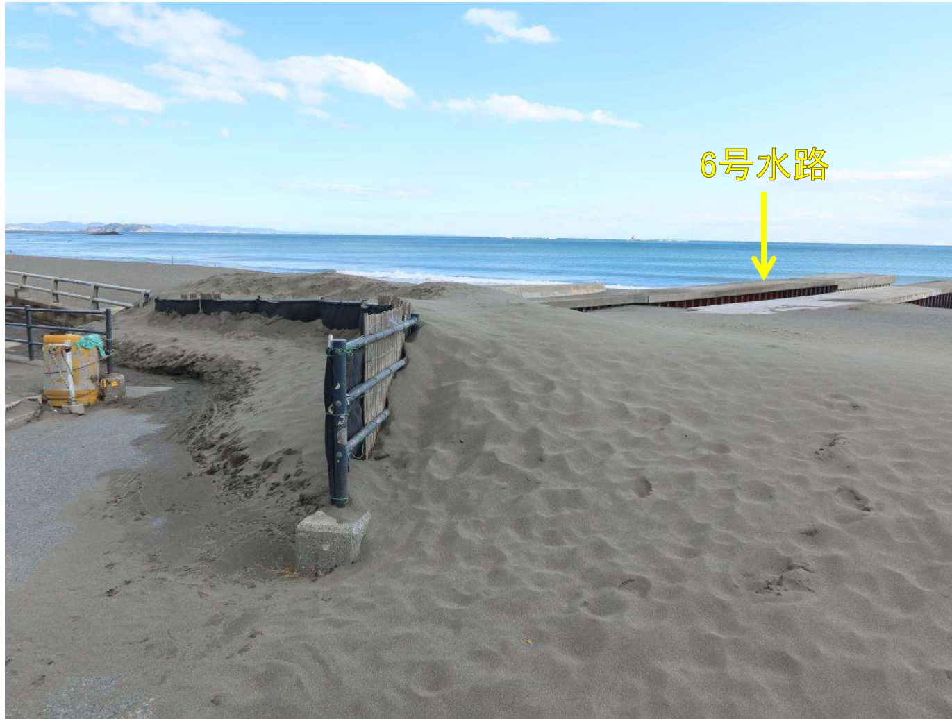
写真-1 サザンビーチの東端に伸びた6号水路付近での飛砂の堆積
