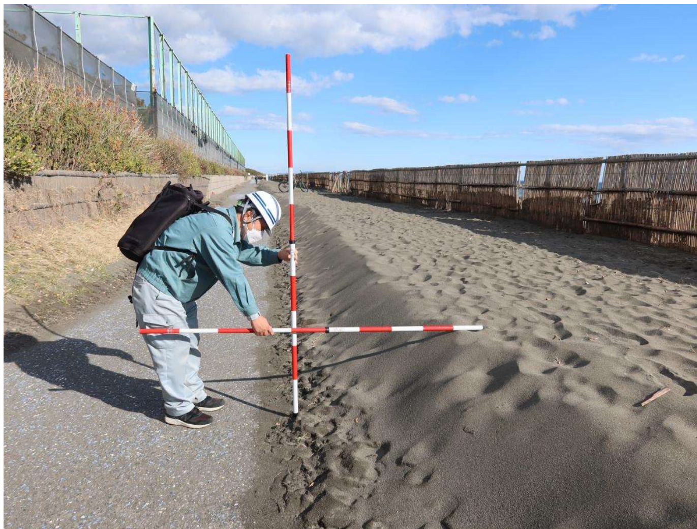
写真-9 除去された後0.5 m厚で残された飛砂
