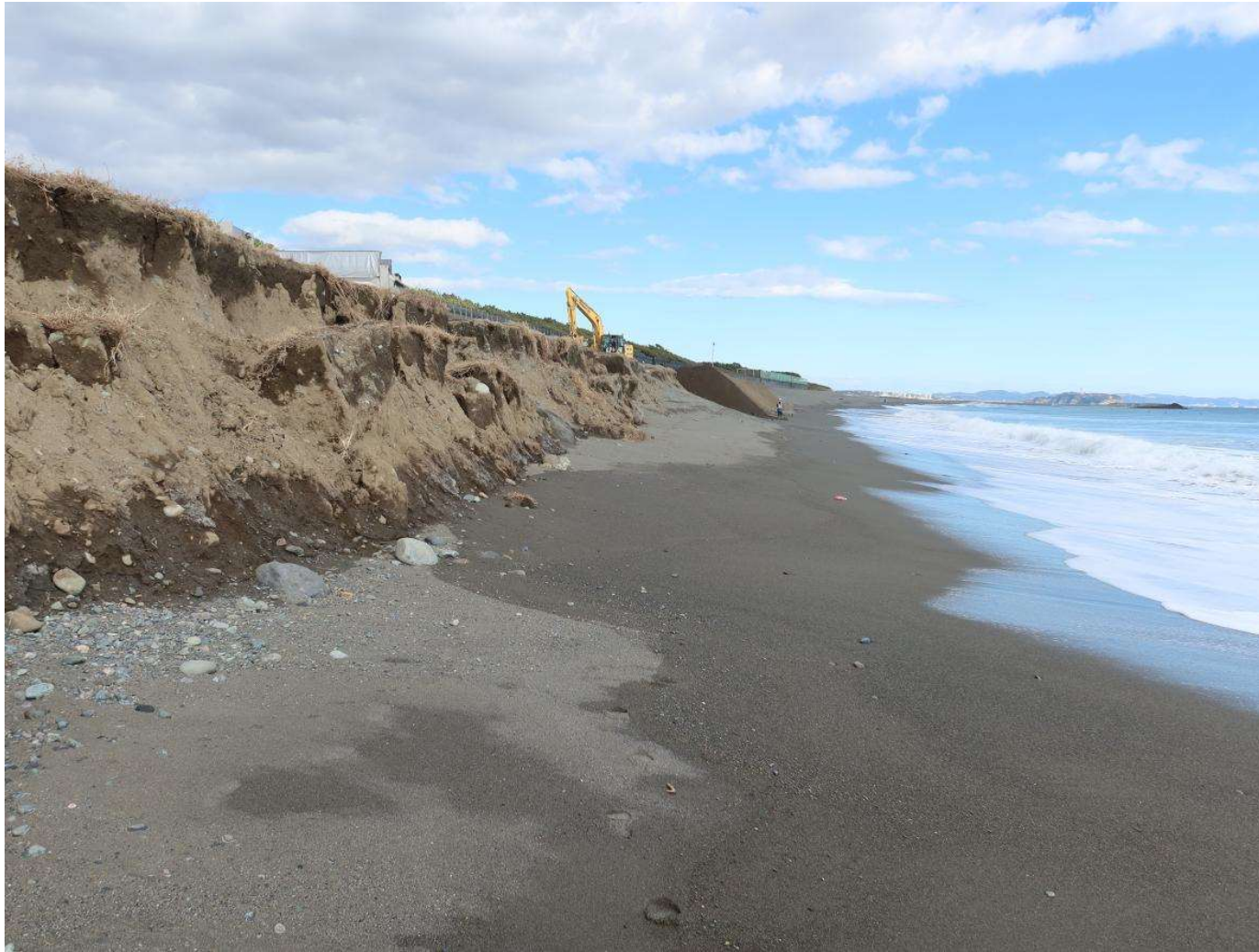
写真-4 茅ヶ崎中海岸地区の養浜盛り土の中央部
