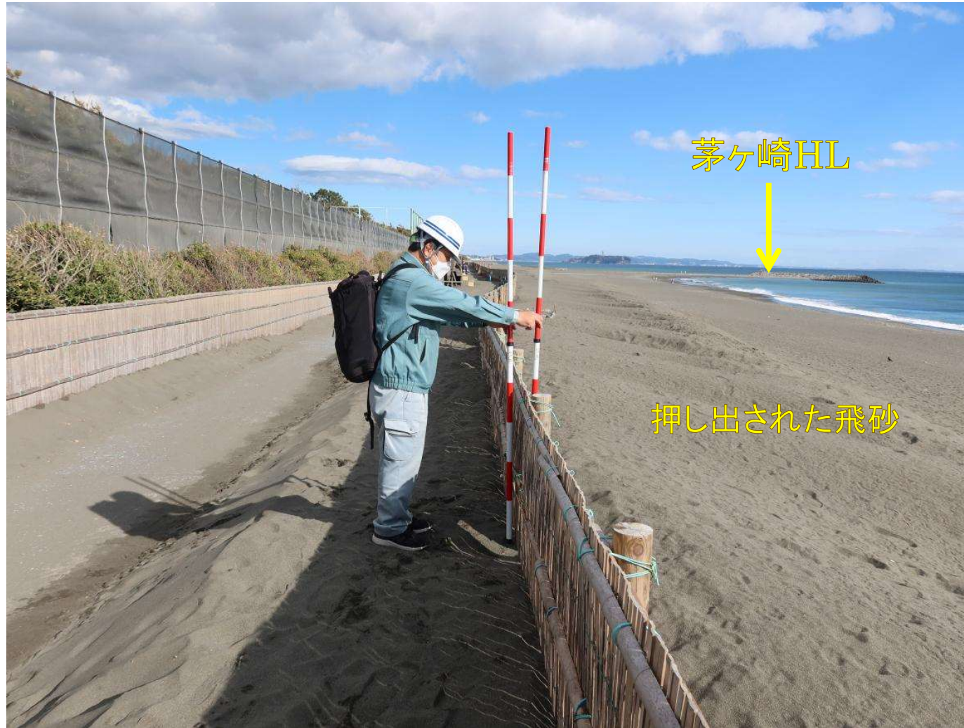
写真-7 堆積した飛砂の除去と堆砂垣の前面に押し出された砂
