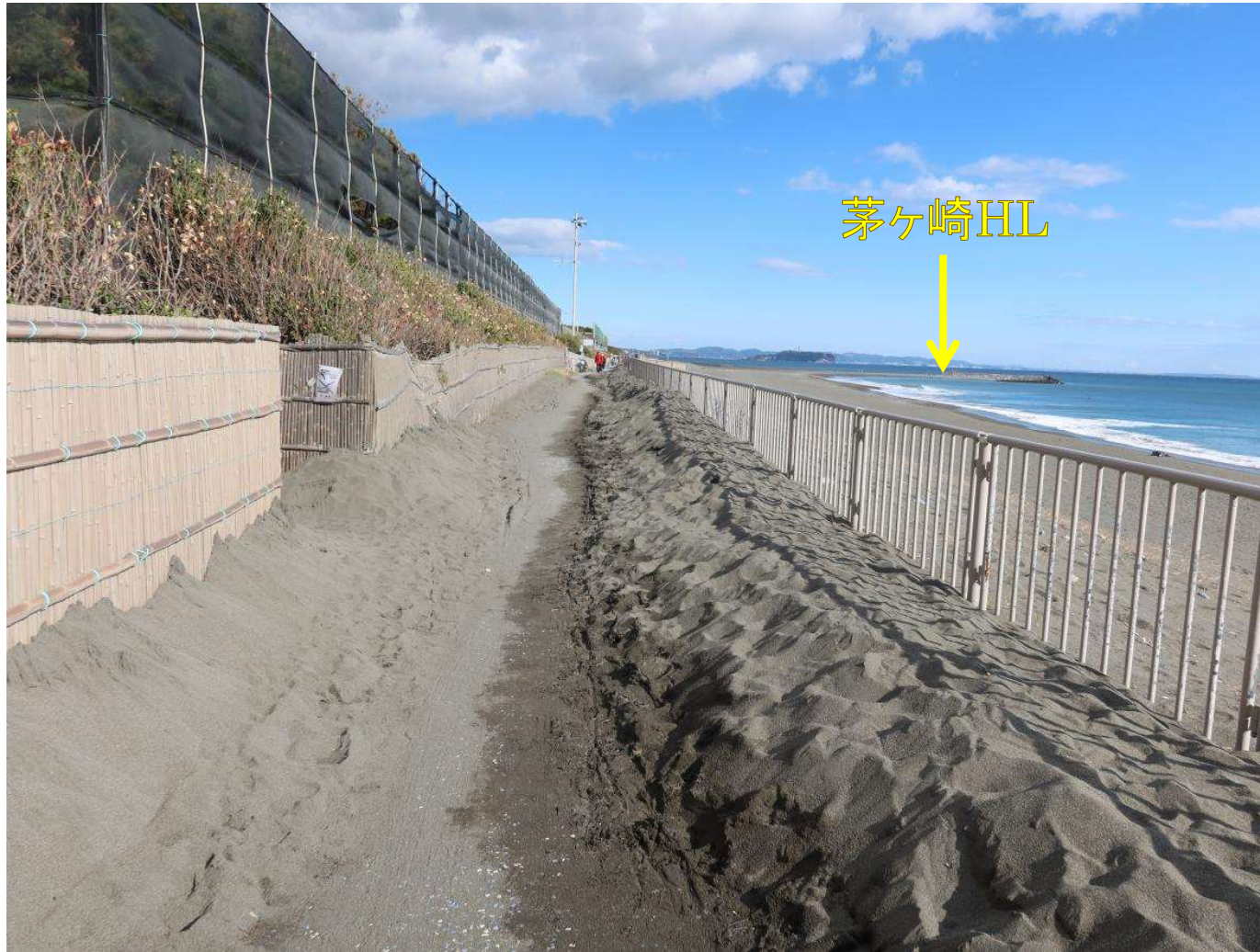
写真-6 茅ヶ崎中海岸地区の自転車道に堆積した飛砂
