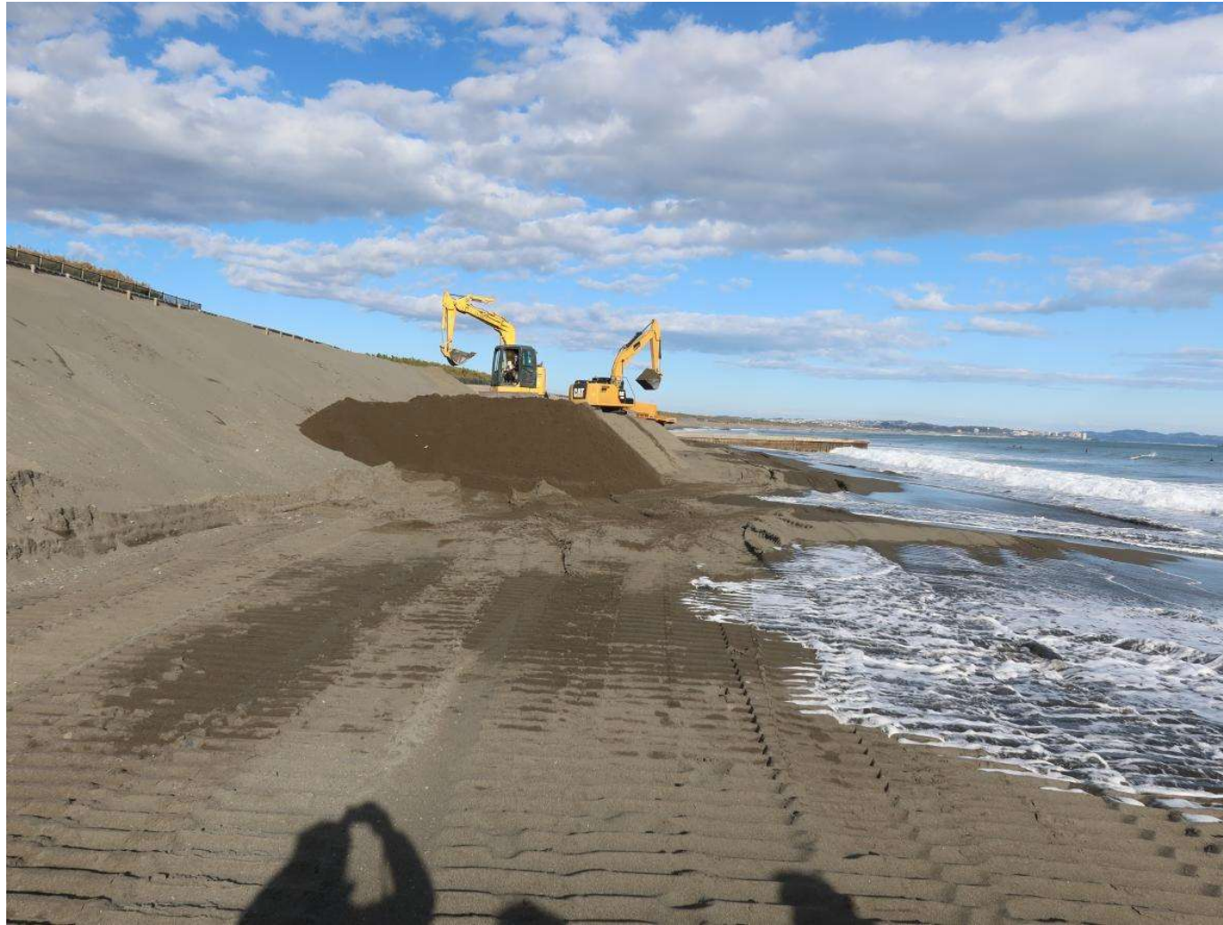
写真-17 砂が運び去られてできた平坦面への波の遡上
