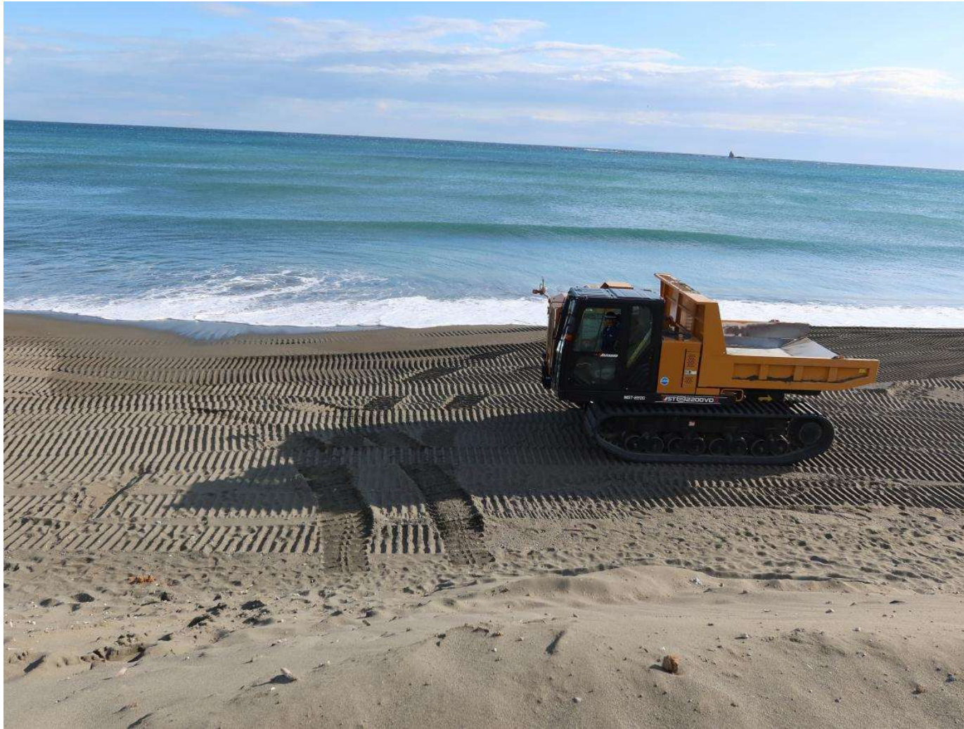
写真-14 養浜砂の運搬に使われている11tのクローラーダンプ
