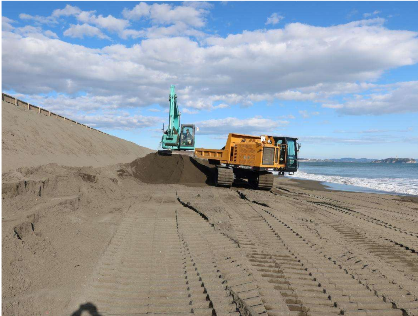
写真-16 重機によるクローラードンプへの積み込み状況
