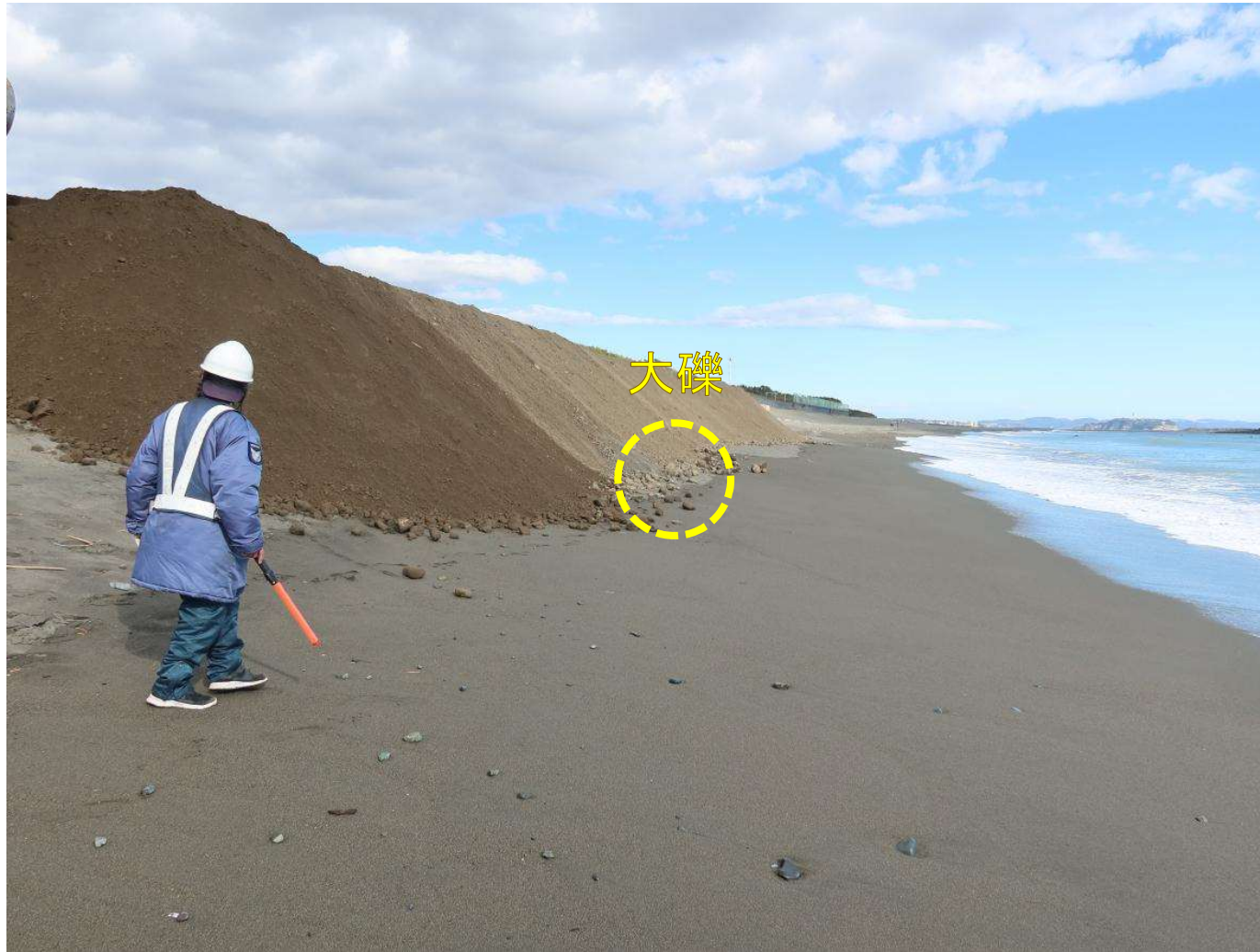
写真-5 新たに行われたばかりの養浜盛り土
