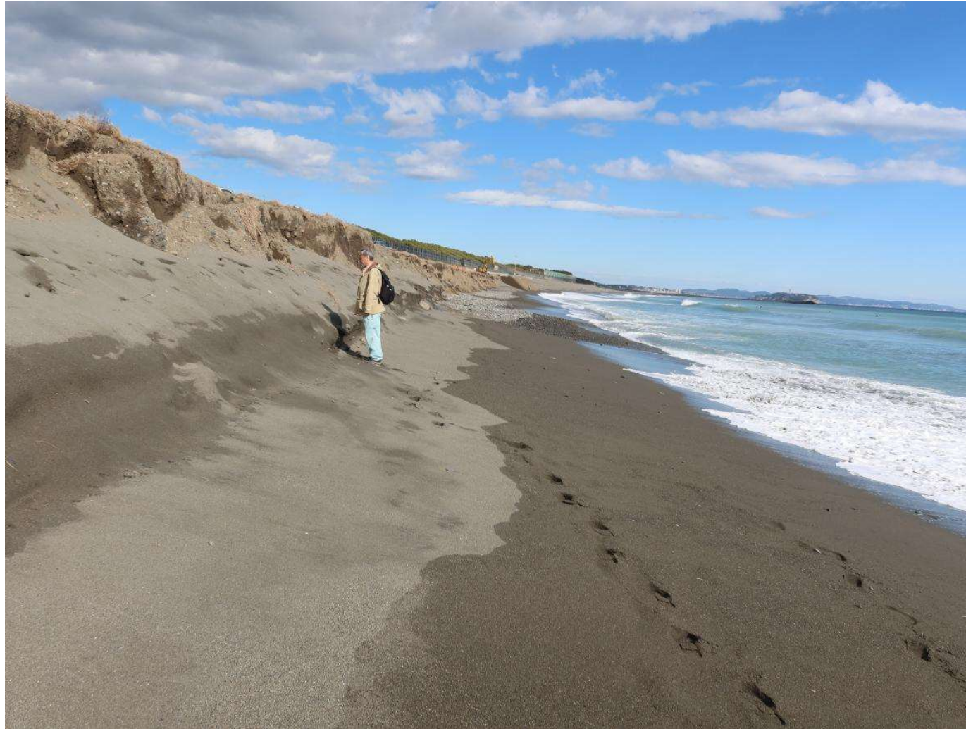
写真-3 茅ヶ崎中海岸地区の養浜盛り土の前面にできた浜崖
