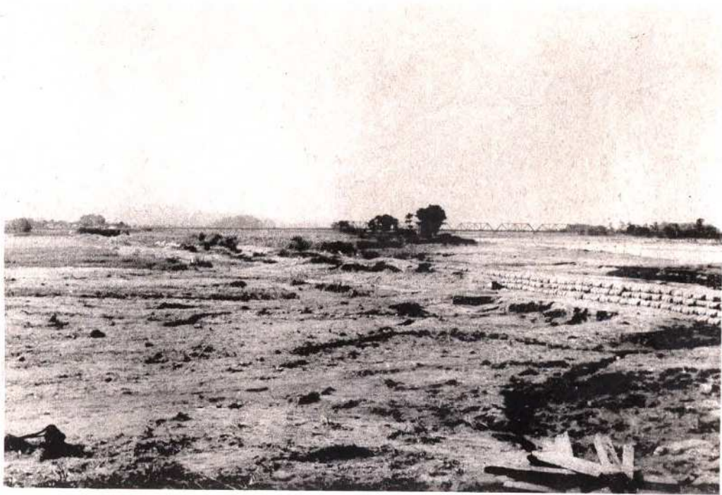
酒匂川堤防の陥落
