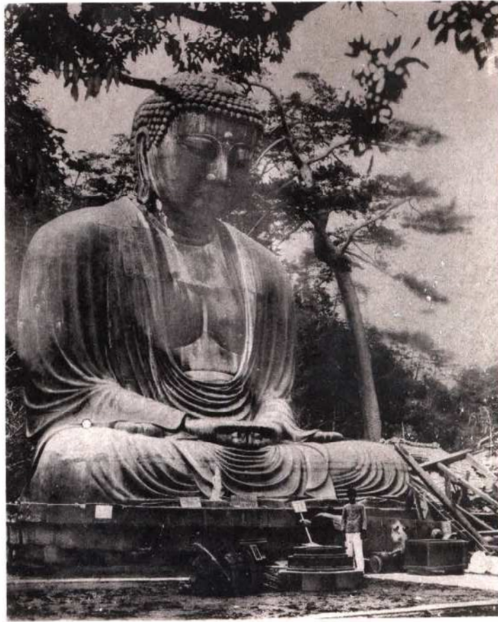
長谷大佛の揺り出し（一尺五寸陥没し約一尺前方に送り出せるが佛像には異状なし）
