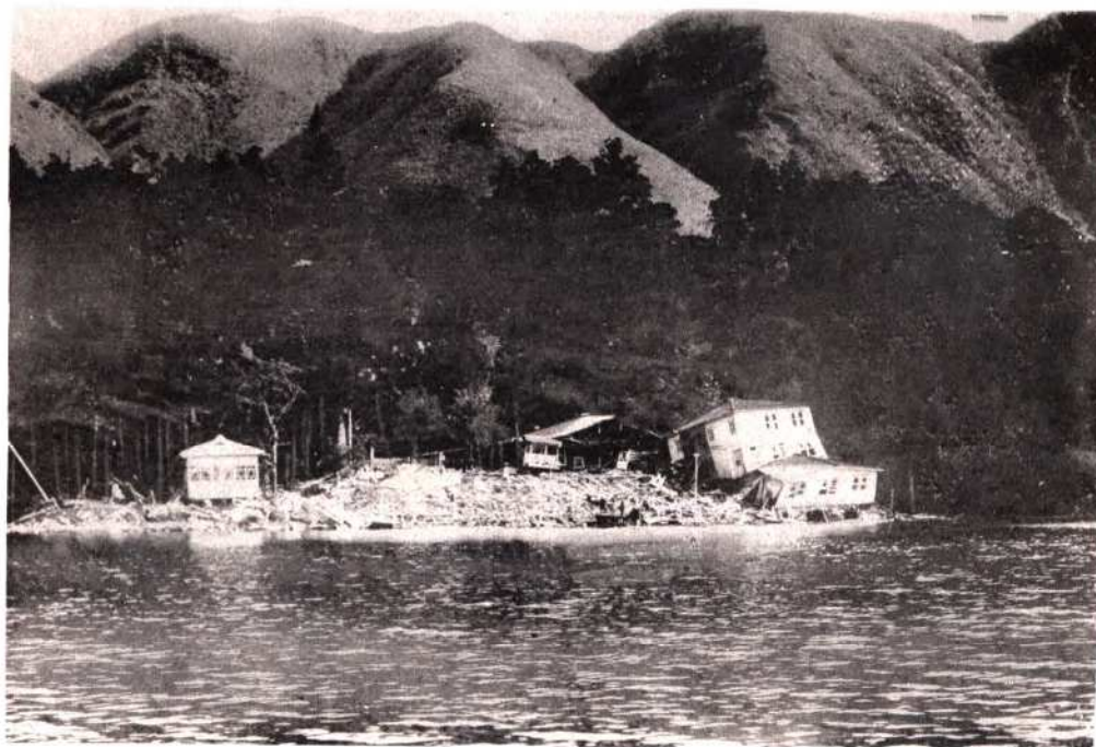
元箱根富士見ホテルの被害
