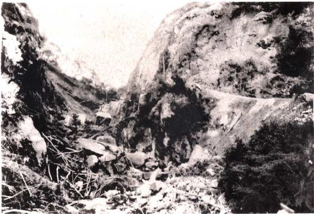
塔澤地内一號國道の閉塞
