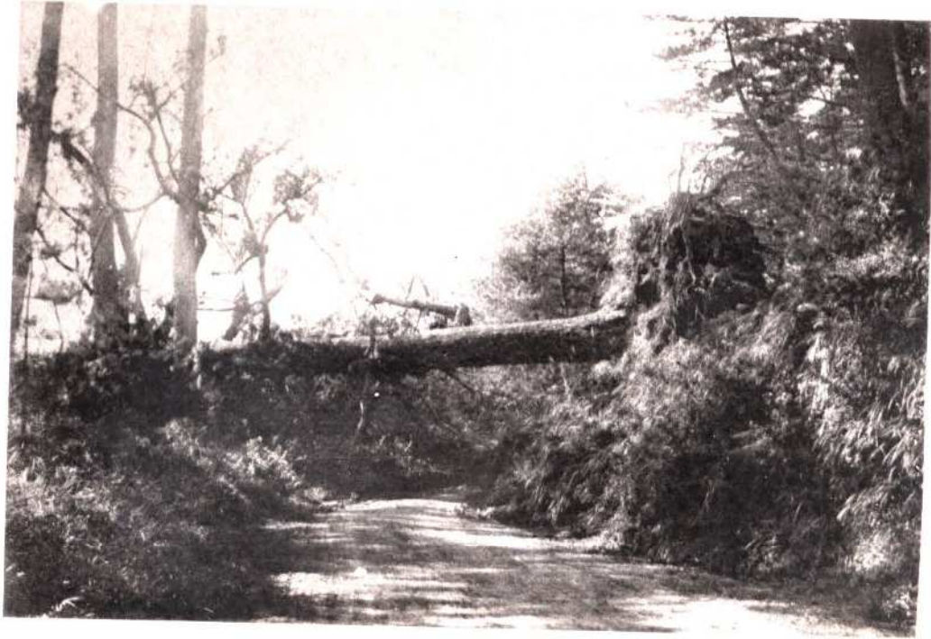
一號國道松並木の被害
