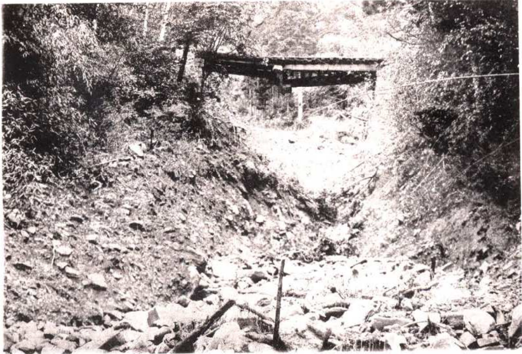
箱根登山電車橋梁の被害
