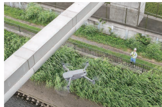
ドローンを活用した水道施設の点検状況
