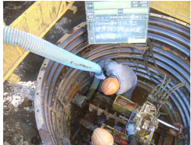
公共下水道の整備 (相模原市)
