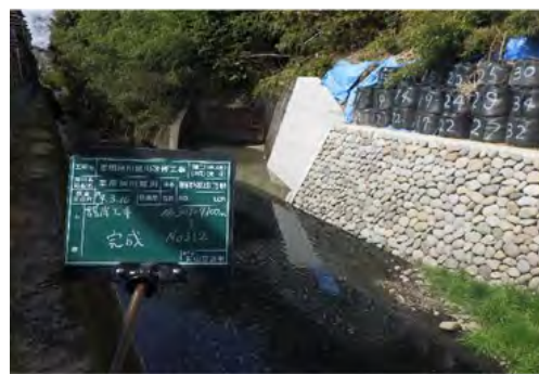
自然石を使用した護岸
