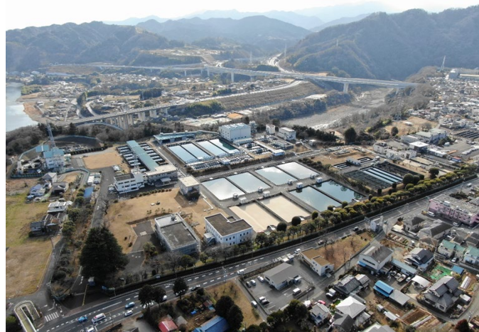
谷ヶ原浄水場
