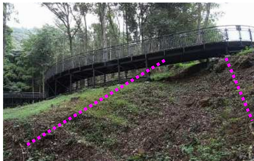
遺構を壊さず園路を整備
