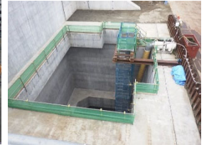
発進立坑（R2.9完成）
