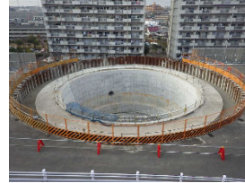
中間立坑（H29.3完成）
