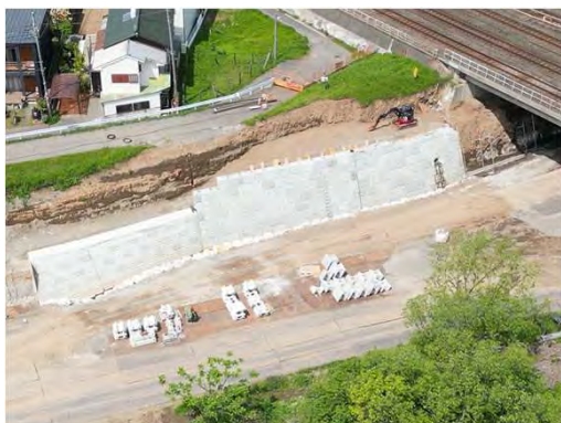
JR東海道本線下流（整備進行中箇所）
