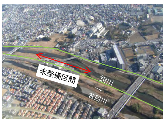
平塚大橋上流（未整備箇所）
