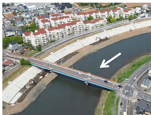
下花水橋付近右岸（整備進行中箇所）
