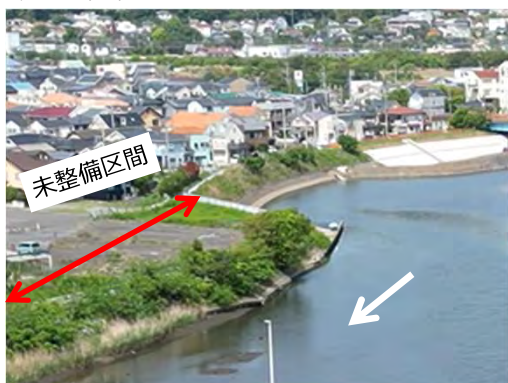
花水川橋上流右岸（未整備箇所）
