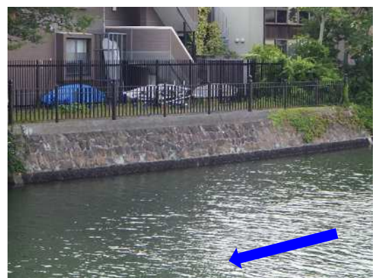
新設護岸の整備状況
