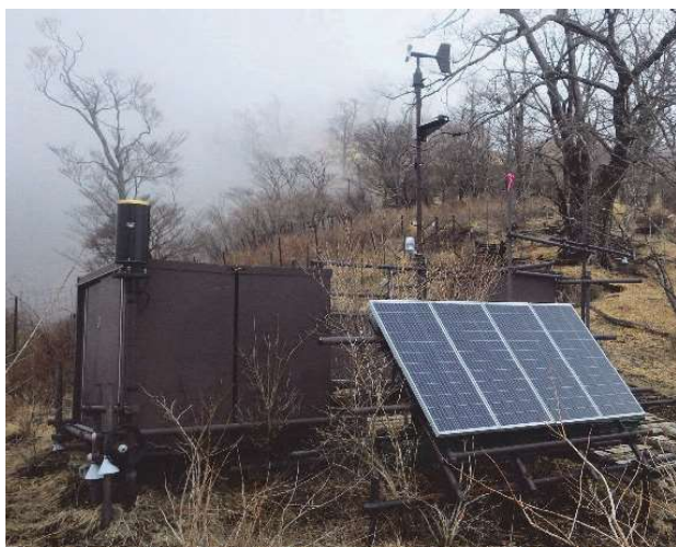
図1 気象観測施設の状況(檜洞丸)
