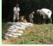
漏水箇所の補修
