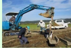
コンクリート水路の更新
