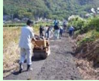
未舗装農道の舗装
