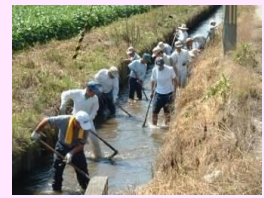
水路の泥上げ
