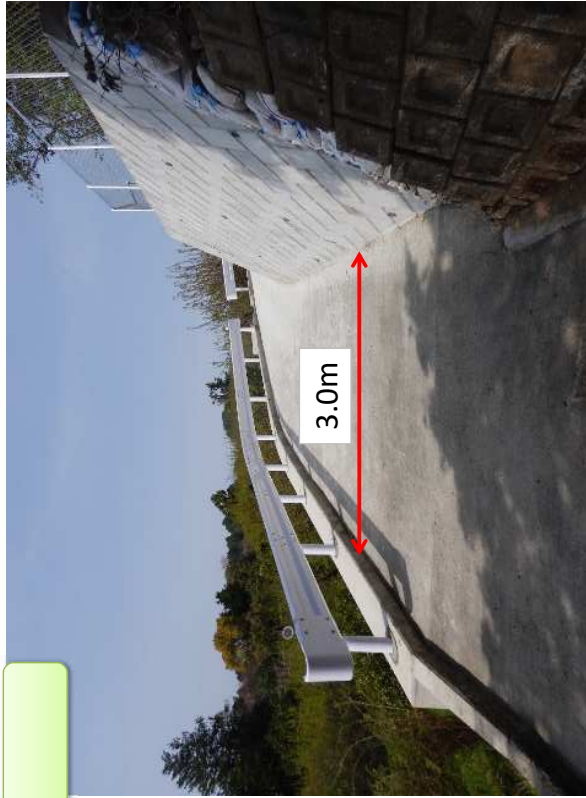
水路兼用農道改修後の様子
