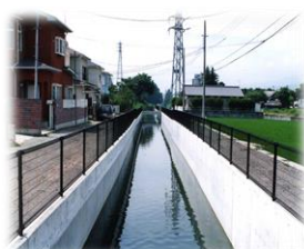
排水路の断面拡幅
