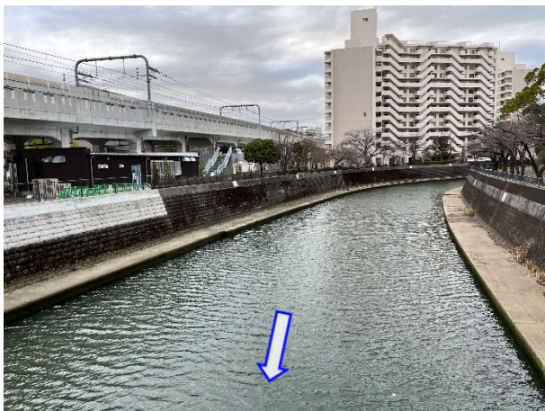
整備済み箇所（古町橋付近）
