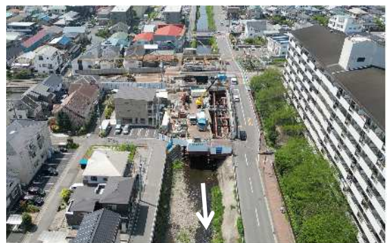
小田急線橋梁（下流側）
