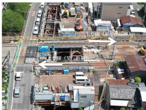
小田急線橋梁（上流側）
