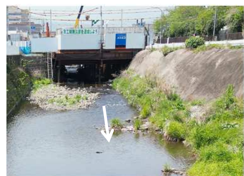
小田急線橋梁下流左岸（整備予定箇所）
