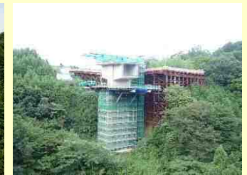
P1柱頭部の施工状況
