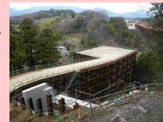
架設前(仮設構台設置後)
