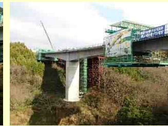
中央併合部の施工状況
