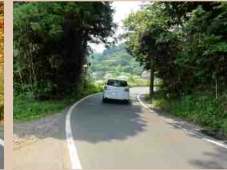
屈曲箇所(曲線半径 R=32)
