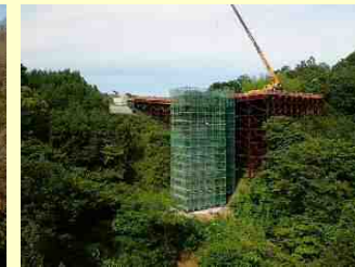
P1縦壁の建設状況
