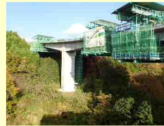
張出部の施工状況
