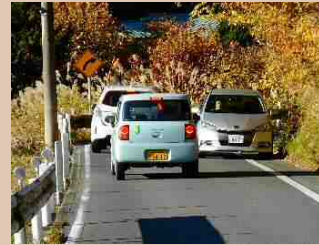
幅員が狭く、歩道が未整備の状況
