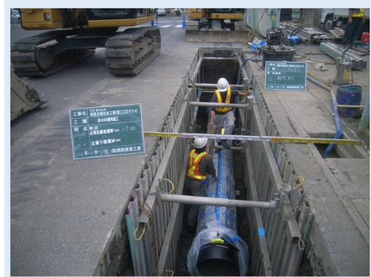
【老朽管更新工事（県企業庁）】
