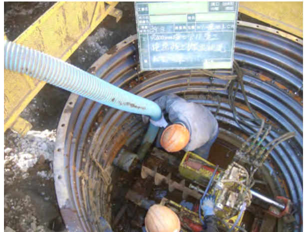
公共下水道の整備 (相模原市)
