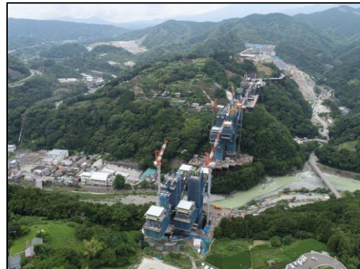
建設中の新東名高速道路（山北町） （令和9年度開通予定）
