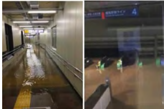
（JR武蔵小杉駅構内内水被害）
