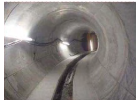
写真2 丸子その1雨水幹線（管内）
