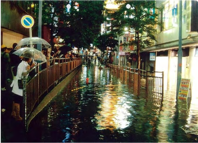
(横浜駅周辺：平成16年台風22号)
