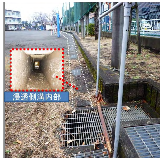
校庭貯留施設
