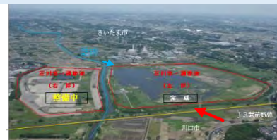
芝川第一調節池
