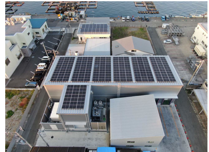
三浦市 城ヶ島水産(株)の設置事例
