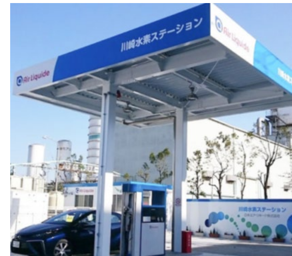
定置式水素ステーションの整備事例
