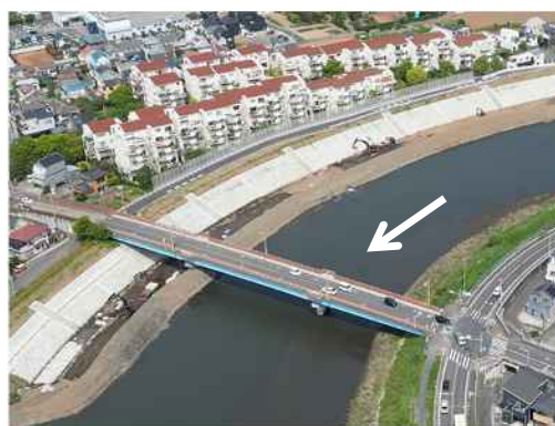
下花水橋付近右岸（整備進行中箇所）
