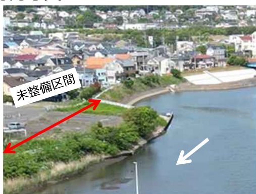
花水川橋上流右岸（未整備箇所）
