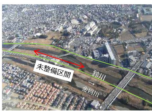
平塚大橋上流（未整備箇所）
