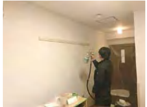
壁クロスへの施工の様子
