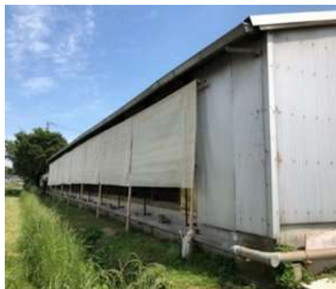
図 5 畜舎の開口部に臭気分解メッシュを設置
