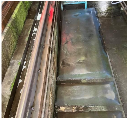
写真5 床面排水状況②
