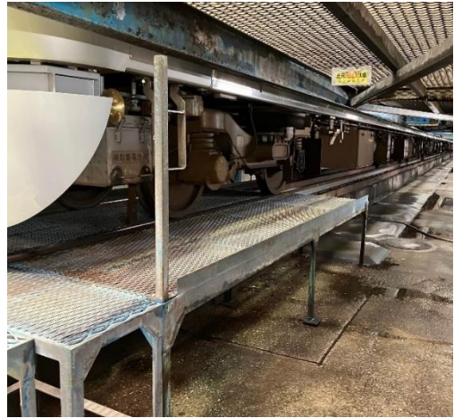
写真4 床面排水状況①
