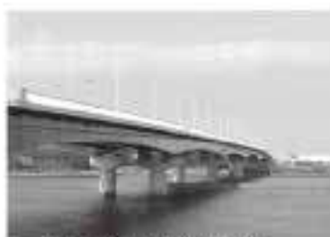
橋りょうの耐震補強（河野川） 船形大橋
