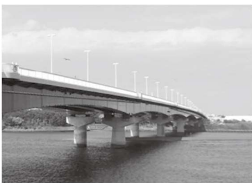
橋りょうの耐震補強（相模川 湘南大橋）
