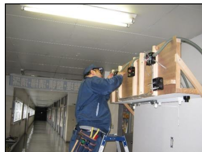
応用実習 (電気工事)
