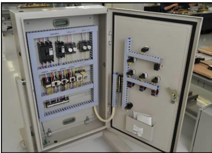
制御盤組立実習
