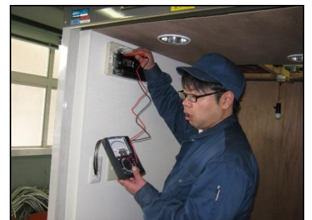
応用実習 (模擬家屋の電気工事)
