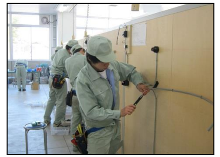
電気工事実習
