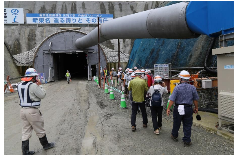
新東名高速道路川西工事 トンネル工事現場へ
