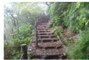
自然公園施設(歩道)の維持・補修管理
