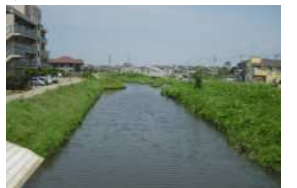
多自然川づくり
