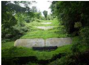
荒廃山地の崩壊防止（土留工）
