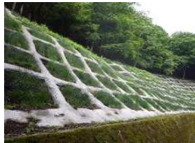
林道の法面保護（簡易法枠工）
