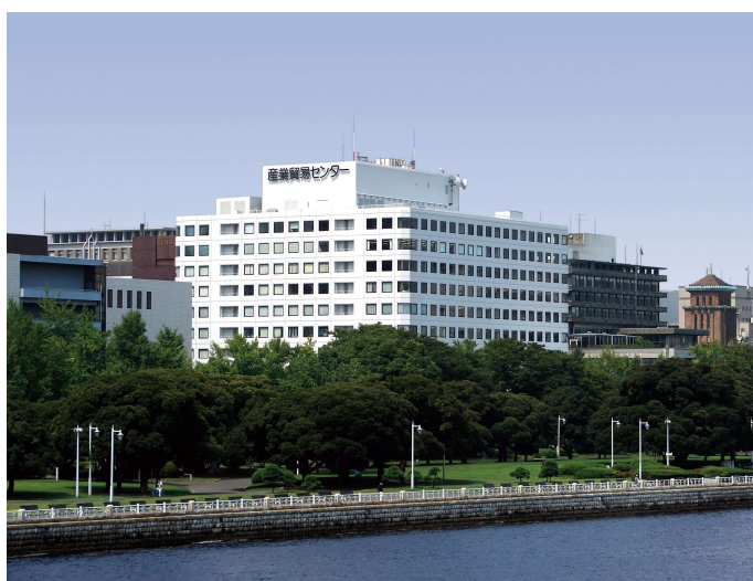
【産業貿易センタービル】
