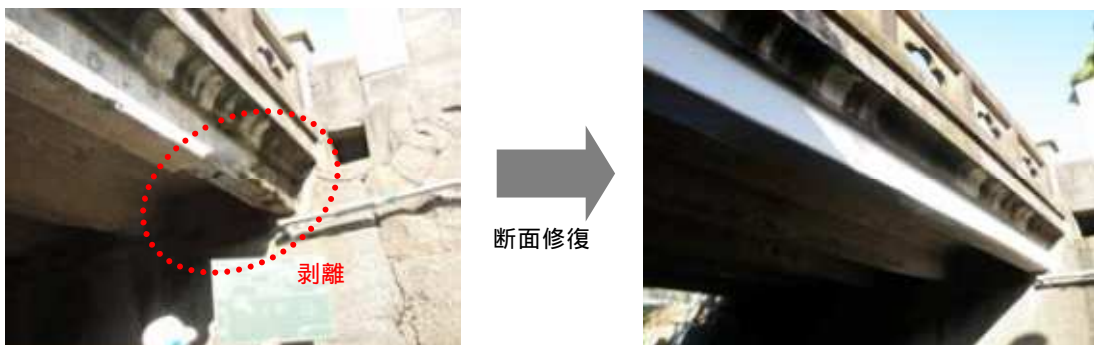
写真3-3 コンクリート桁の断面修復
