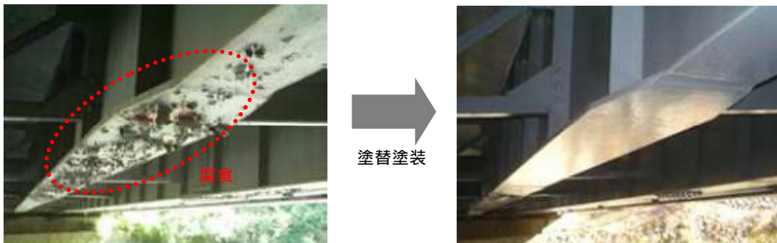
写真3-2 鋼桁の塗替塗装
