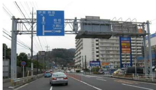
写真2-6 門型標識(国道135号 / 湯河原町)
