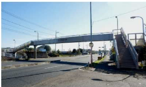
写真2-5 及川八幡神社前歩道橋(国道412号 / 厚木市)
