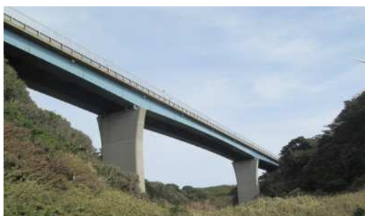
写真2-1 宮川大橋 (県道215号(上宮田金田三崎港)/三浦市)
