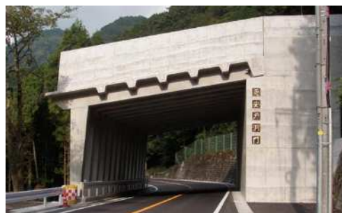
写真2-4 芝安戸洞門 (県道76号(山北藤野)/山北町)
