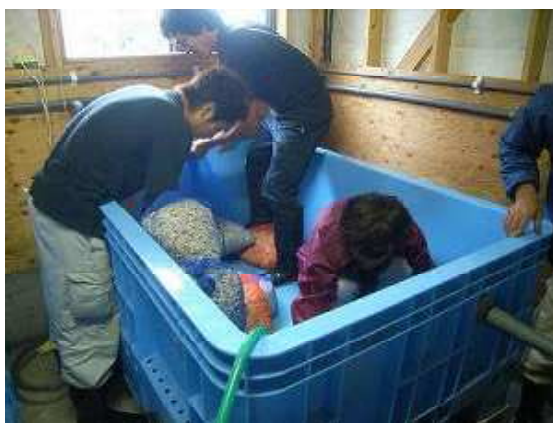
図 7-13 アワビの陸上養殖水槽に濾材を敷詰める作業
