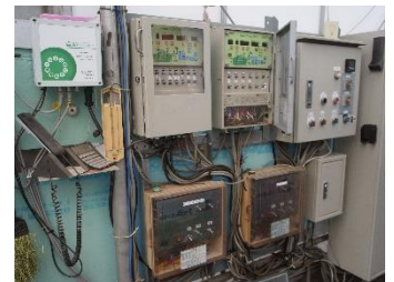
複合環境制御盤
